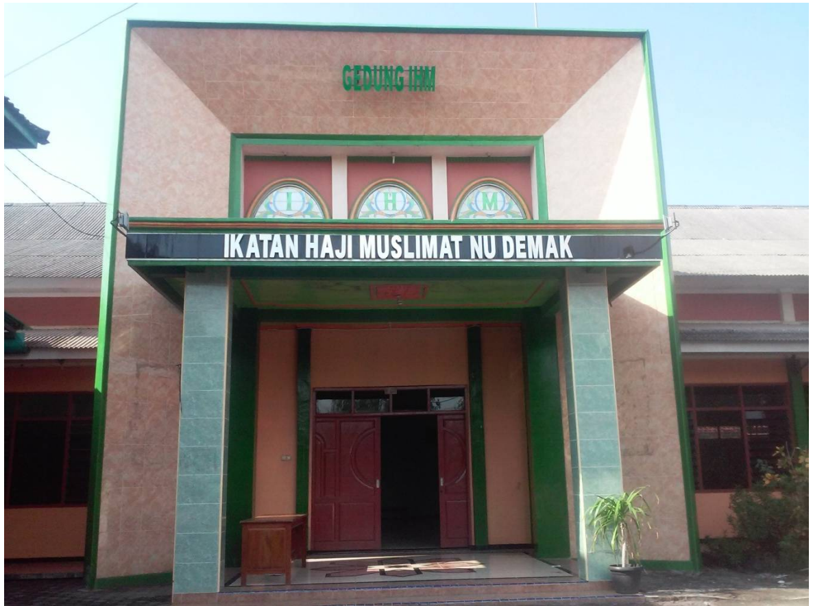
Gedung IHM yang berfungsi Sebagai Gedung Persewaan serbaguna
