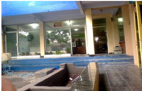
Kondisi Ruang Guru
