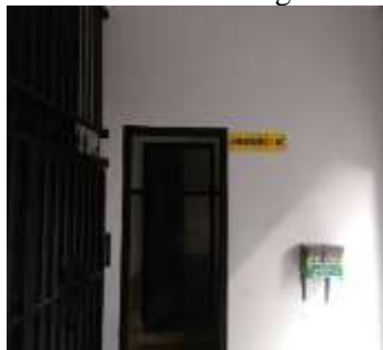
Gambar 9. Ruang mandi lantai I
