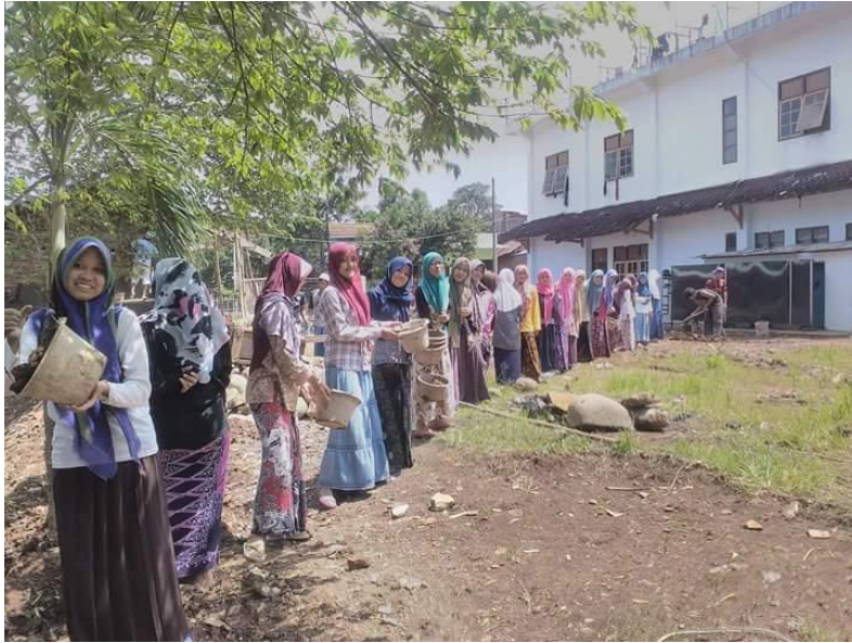
Gambar 12. Pembangunan PPMQA Putra 2017
