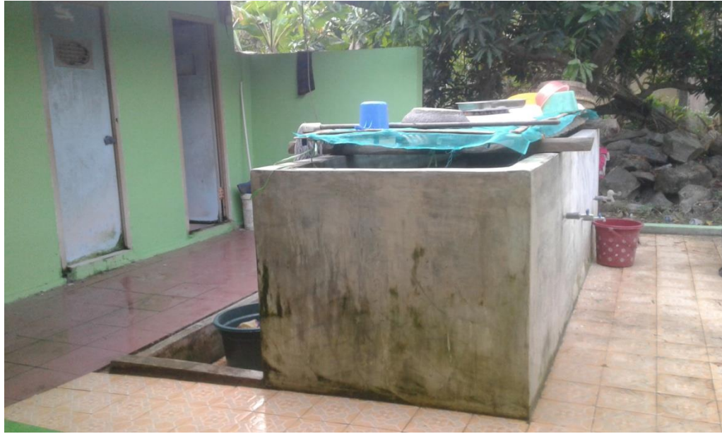
Penambahan fasilitas berupa toilet dan tempat wudlu
