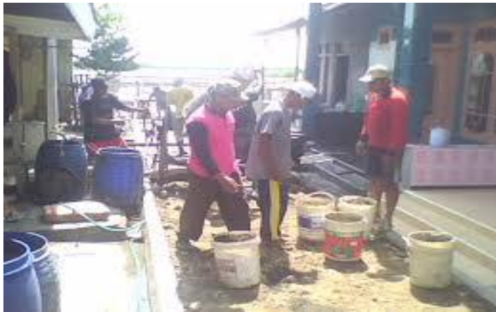
Gotong-royong pembangunan jalan
