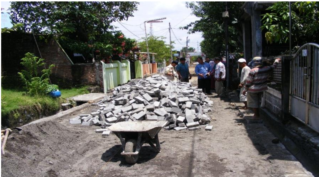
Proses Perbaikan Saluran Drainase
