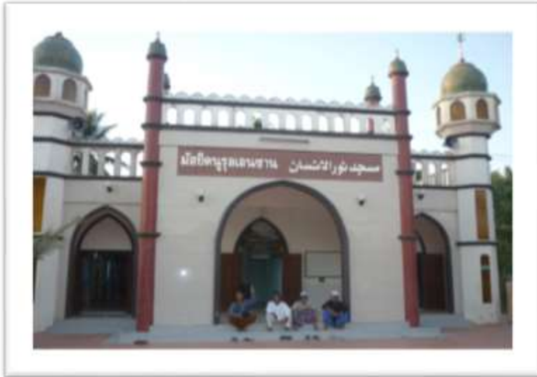
Gambar I : Bangunan Masjid Nurul Insan Sabarang
