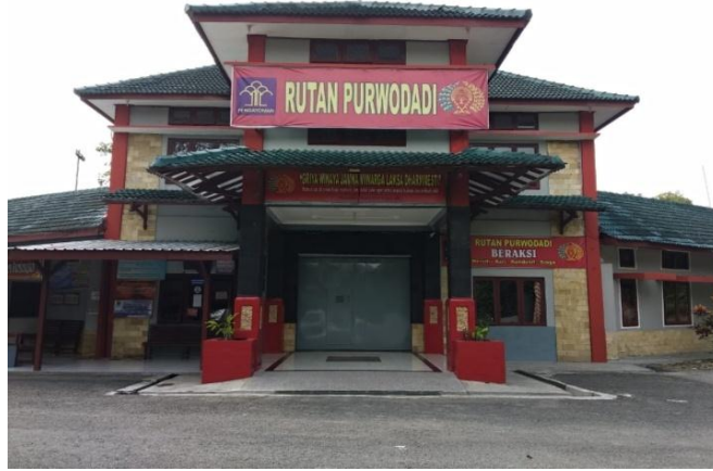
Bangunan depan Rutan Klas IIB Purwodadi Grobogan
