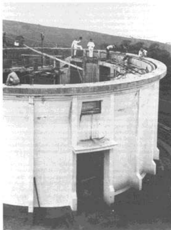
Gambar 3.3. Pembangunan Observatorium Bosscha 21
