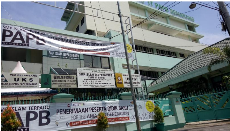
Gambar 4.2. Gedung SMP IT PABP
