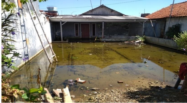
Gambar 3 Kondisi Fisik Bangunan Rumah Penduduk
