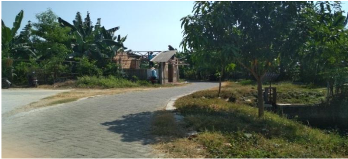
Gambar 13. Perbaikan jalan oleh Dinas Pekerjaan Umum
