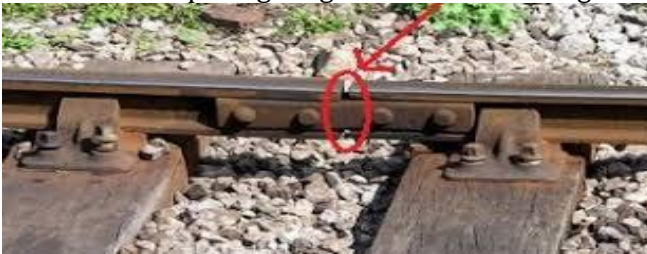
Gambar 2.2 Pemasangan rel kereta api
