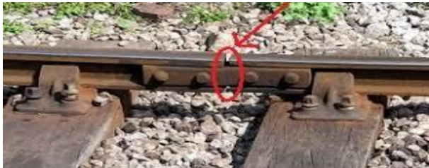
Gambar 2.2 Pemasangan rel kereta api
