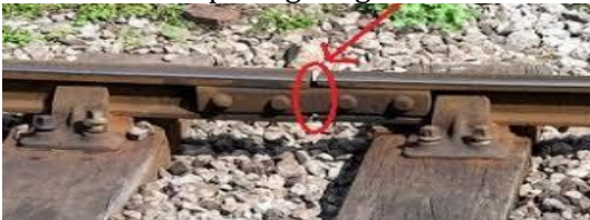
Gambar2.2 Pemasangan rel kereta api
