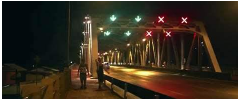
Gambar 11. Mada dan Glen sedang menyusuri trotoar jembatan layang. (Scene 3)
