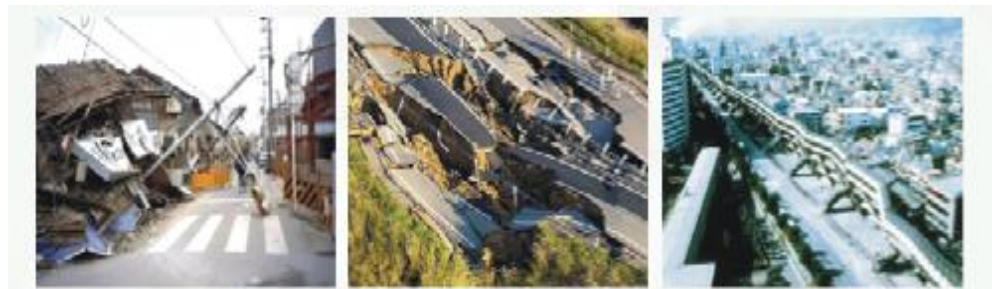
Gambar 1.7 Kerusakan infrastruktur yang ada di kobe Jepang
