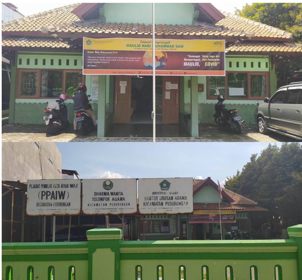
Dokumentasi Keadaan KUA Pedurungan
