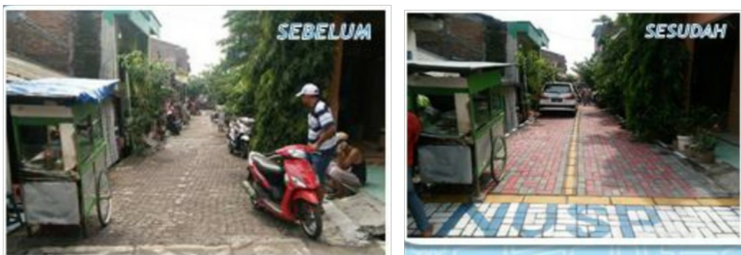
Gambar 3.3. Kondisi jalan dan DRAINASE sebelum dan sesudah Program NUSP 2018 dijalankan.
