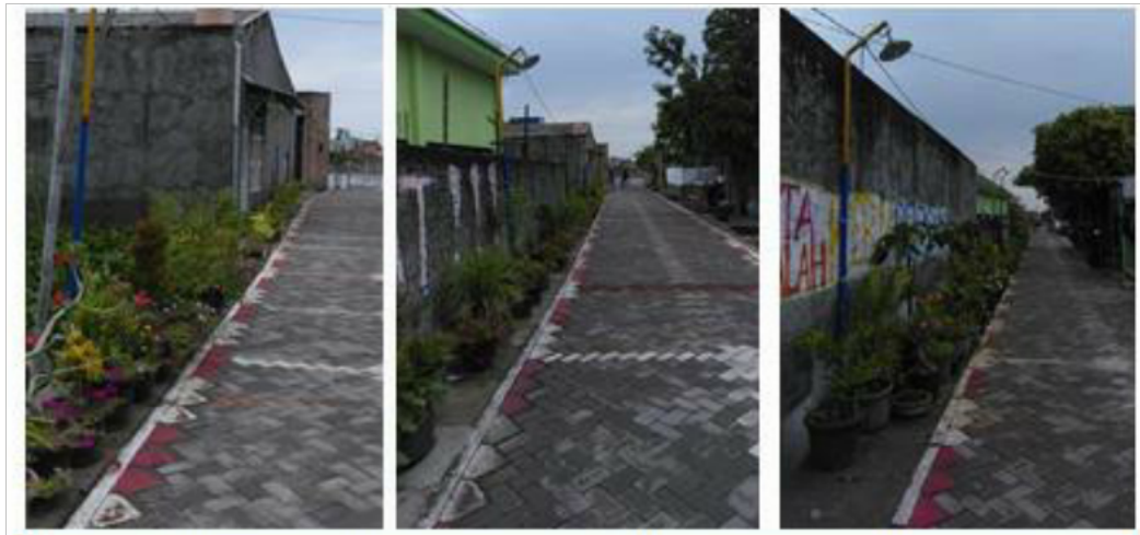
Gambar 3.4. Kondisi Peninggian dan peningkatan jalan paving dan perbaikan saluran
