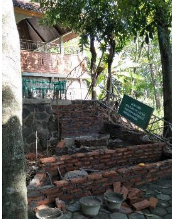
(Pembangunan Tangga Jalan Belakang Makam pada 30 Oktober 2020)
