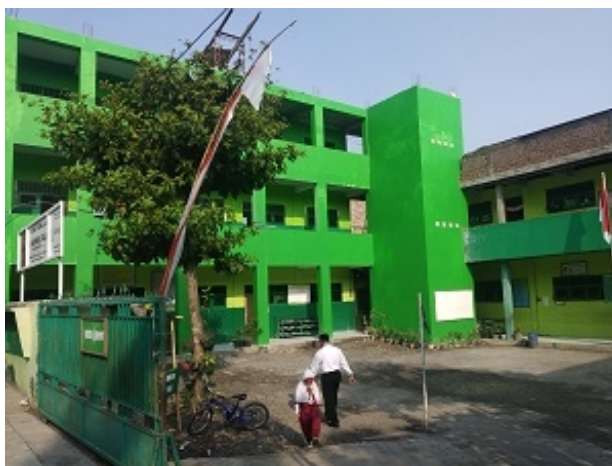
Gambar 4.3 Kondisi Bangunan MI Nashrul Fajar 61
