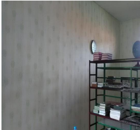
Gambar 2 : Dinding ruangan perpustakaan sudah dilakukan proses revitalisasi dengan pemasangan wallpaper
