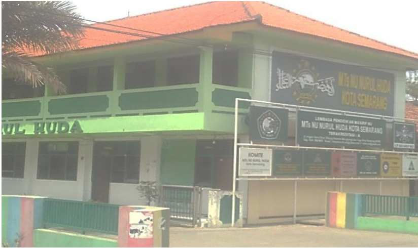
Gedung Sekolah MTs NU Nurul Huda Mangkang
