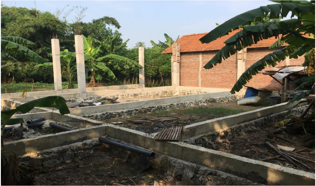
Gambar 9 Pembangunan Gedung Asrama 2
