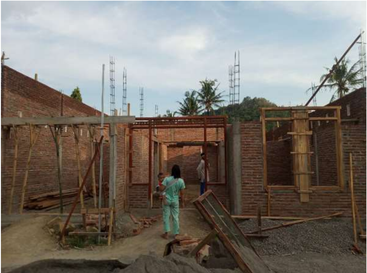
Dokumentasi : Membangun Rumah Baru
