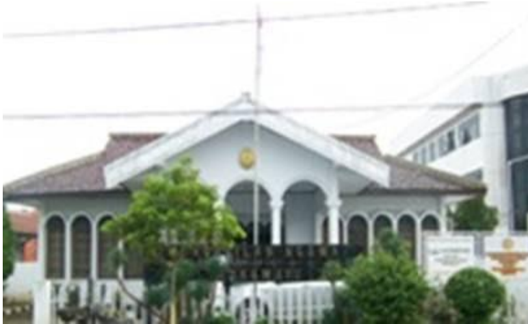
Gambar 3.1 Gedung Lama Pengadilan Agama Indramayu
