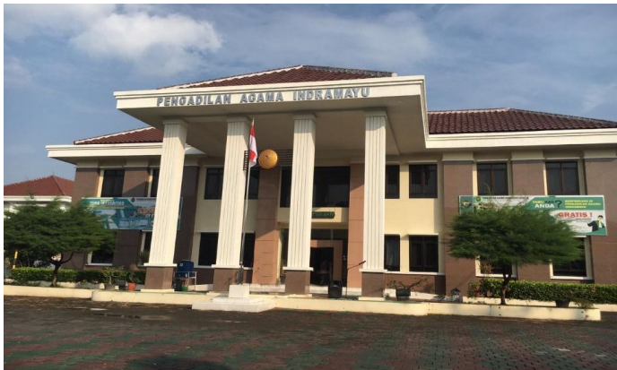
Gambar 3.2 Gedung Baru kantor Pengadilan Agama Indramayu
