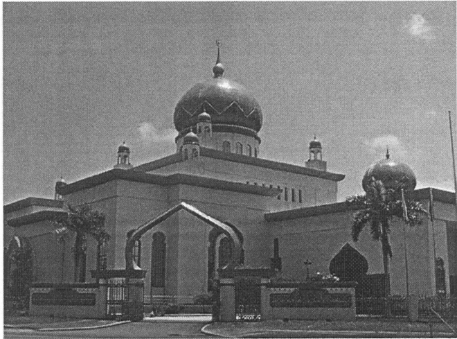
Foto Masjid Al-Ameerah Al-Hajjah Maryam tampak dari sudut samping
