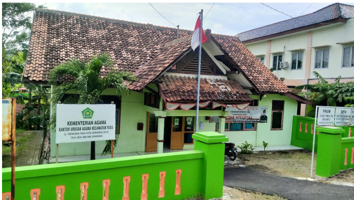
Gambar 3 Bangunan KUA Kecamatan Tugu
