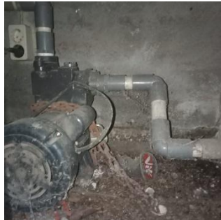
Gambar D21 Pengambilan sampel air tanah di area 9 & 10
