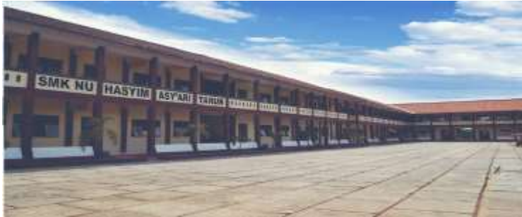
Gambar 4.11 : Prasarana Gedung SMK 99
