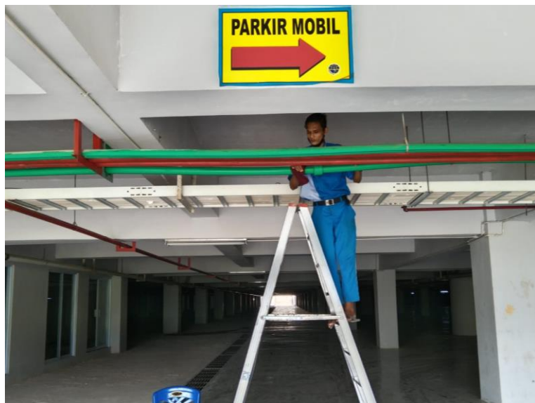
Gambar 32. Pembersihan Area Basement
