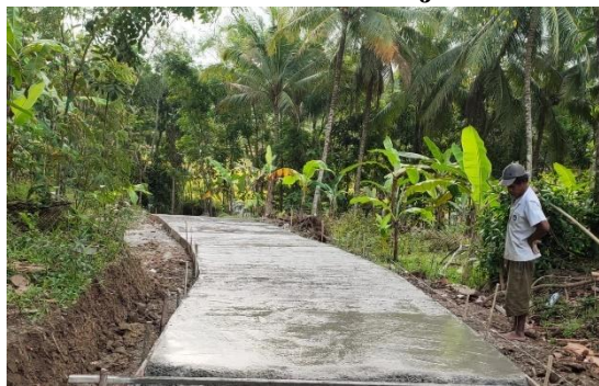
Gambar 4.5 Pembuatan Jalan Akses Menuju Desa Wisata
