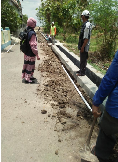
Gambar 8. Proses Pemasangan Pipa Program PAMSIMAS Ke Rumah Masyarakat Desa Grinting
