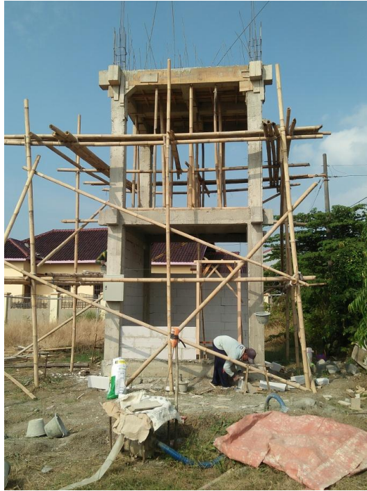
Gambar 6. Proses Pembangunan Menara Program PAMSIMAS Desa Grinting
