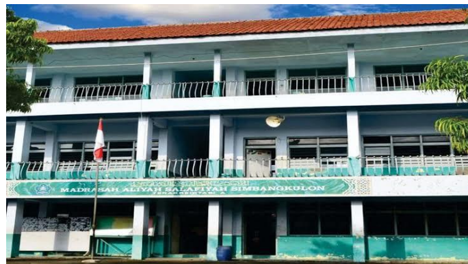
Gedung MAS Simbang Kulon
