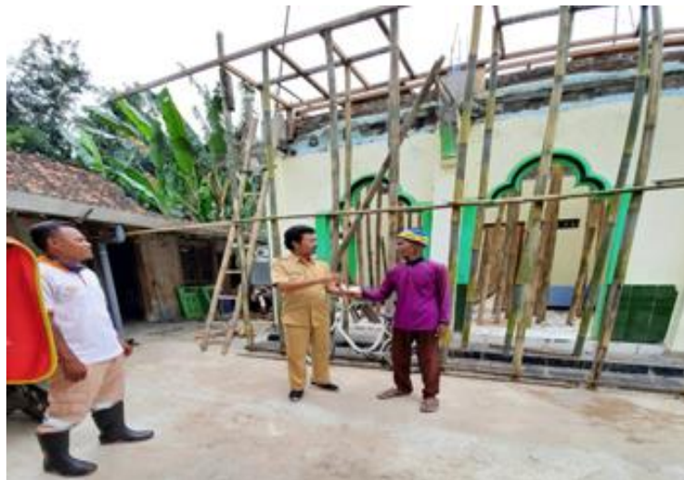
Gambar 5. Kegiatan Pembangunan Tempat Ibadah (Mushola)
