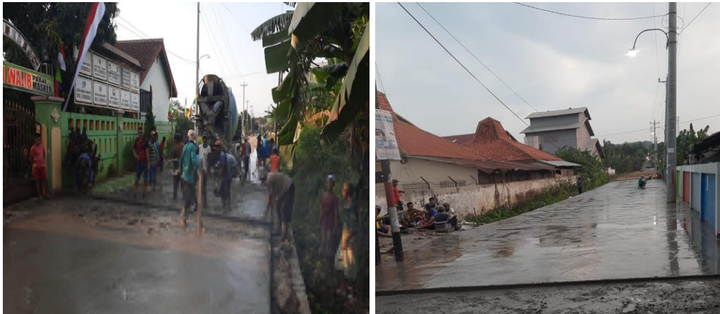
Gambar 3. Pengecoran atau Rabat Beton Jalan Kyai Sukin
