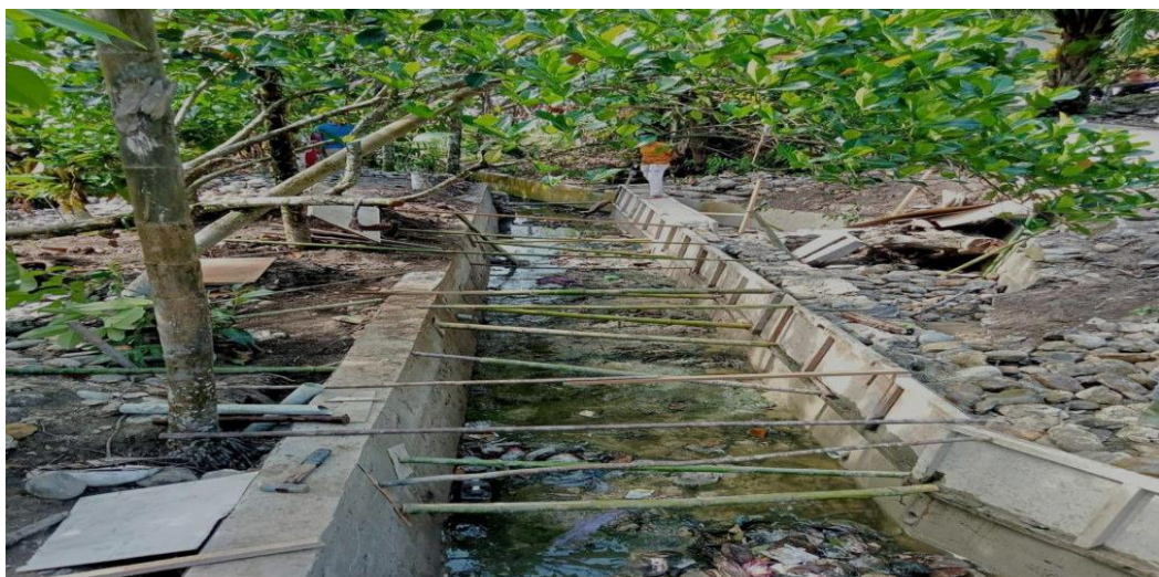
Gambar 3. 7 Pembangunan Saluran Irigasi
