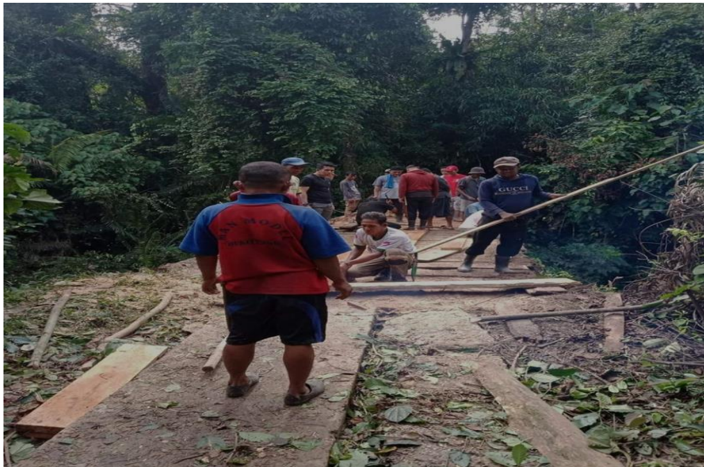
Gambar 4. 4 Pelaksanaan Perbaikan Jalan
