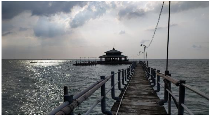
Gambar 4.14 Kondisi jembatan untuk menuju ke makam Syekh Mudzakir
