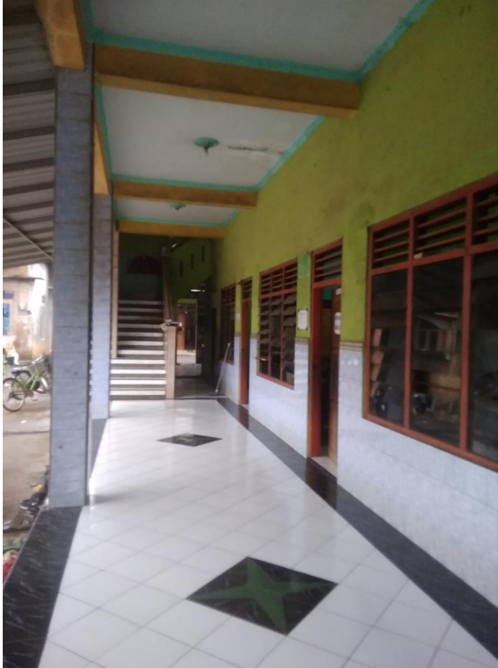
Gedung SDIT Makarimal Akhlak
