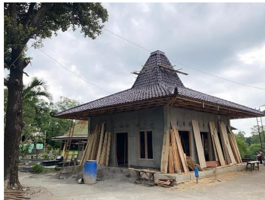
Pembangunan Mushola (Sumber: Dokumen Pribadi)
