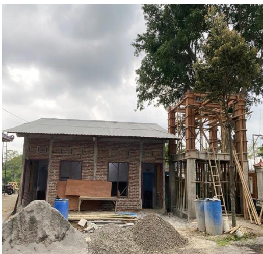
Proses Pembangunan mushola
