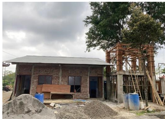
Pembangunan toilet dan kantor (Sumber: Dokumen Pribadi)
