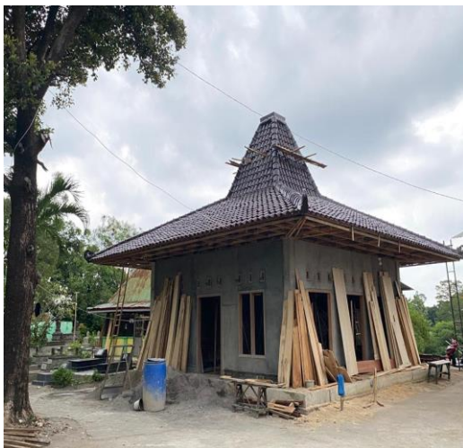
proses Pembangunan toilet & kantor
