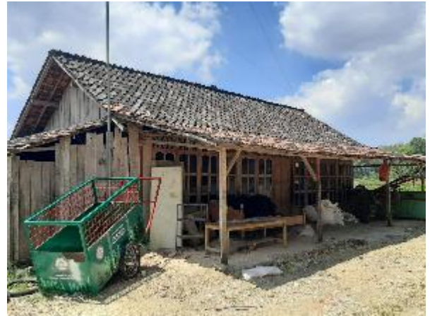
Gambar 8. Bantuan Bangunan Pengolahan Sampah Oleh PT. Semen Indonesia
