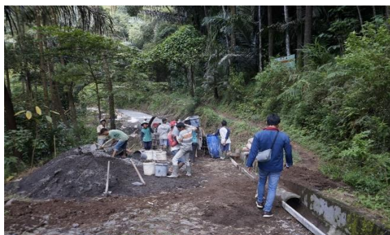
Gambar 4. 2 Perbaikan jalan dusun Separe
