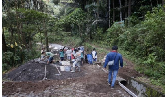
Perbaikan jalan dusun Separe, (Sumber : Dokumentasi Pribadi 2022)
