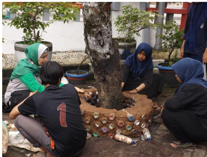
Proses pembuatan ecobrick bangunan luar ruang yang akan dijadikan pot
