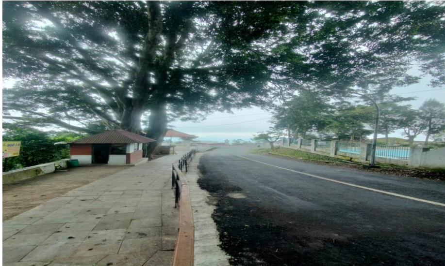
Gambar 15. Kondisi Jalan Menuju Lokasi Wisata Jumprit.
