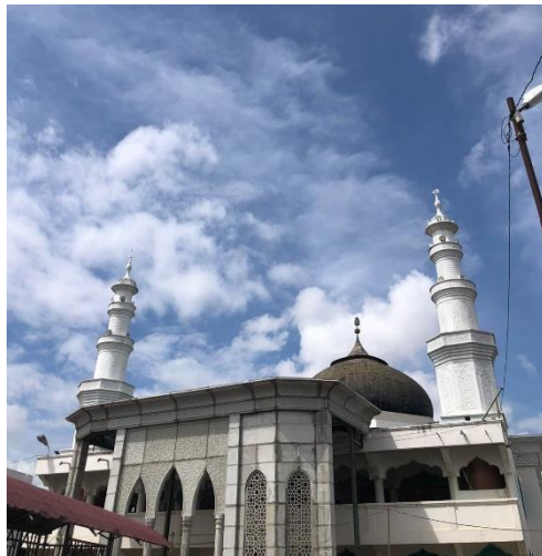
Gambar 3.2 : Bagian belakang Masjid Al-Ishlahiyah
