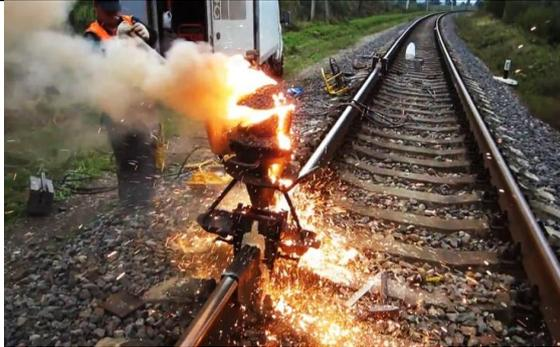
Pada proses pengelasan rel kereta api, umumnya digunakan proses termit, yaitu reaksi antara logam aluminium dengan besi(III) oksida menghasilkan logam besi dan panas yang dihasilkan dapat melelehkan permukaan rel.
