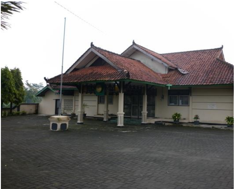
Gedung PA Purworejo lama tahun 1996
