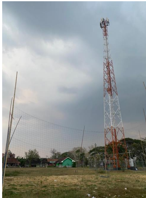
Gambar 5: Kondisi Tower Desa Menduran
