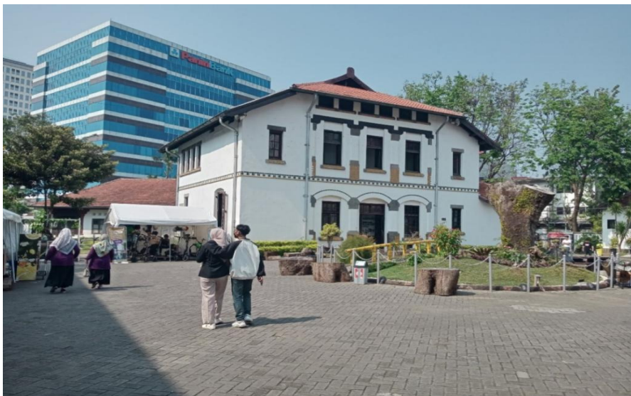
Foto 4 : Gedung C Lawang Sewu
