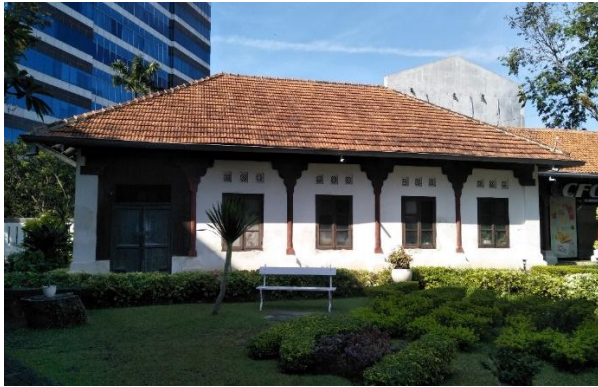
Foto 7: Gedung D Lawang Sewu
