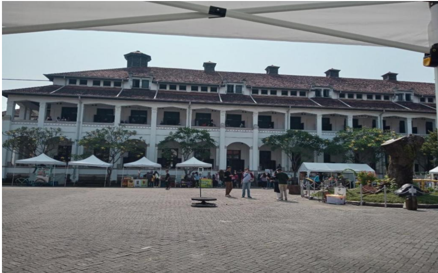
Foto 3 : Gedung B Lawang Sewu
