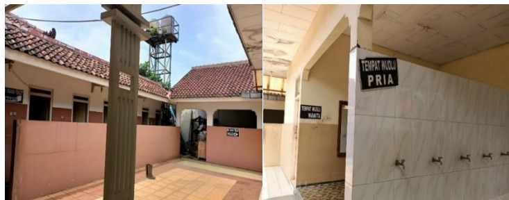
Gambar 3.9 Toilet dan Tempat Wudhu
