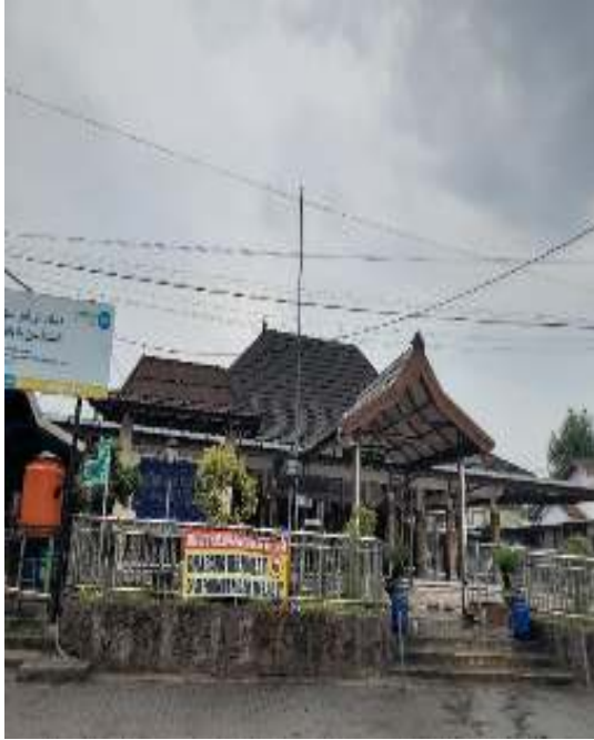
Masjid Sunan Kalijaga tampak depan
