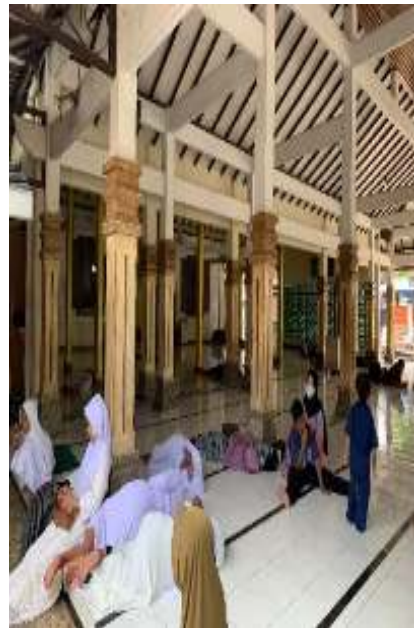
Serambi baru tiang terbuat dari beton
