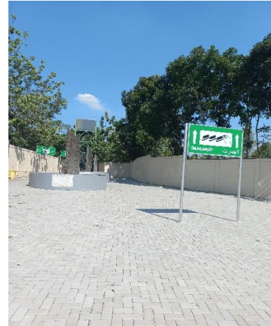
Gambar 3. 29 jalan Akses menuju pelemparan Jumrah
